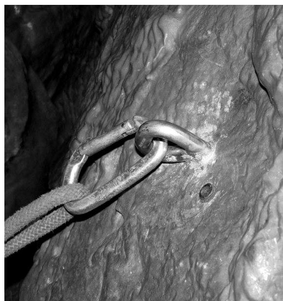
Fot. 1. Wymiana zniszczonego punktu na nowy ze stali nierdzewnej
